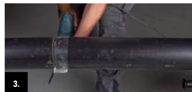
3. Розріжте трубу вздовж лінії розрізу за допомогою наявної у продажу пилки з полотном для пластику.
