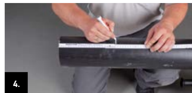
4. Відмітьте на обсадній трубі довжину зачистки 22,5 см від кінця труби.
