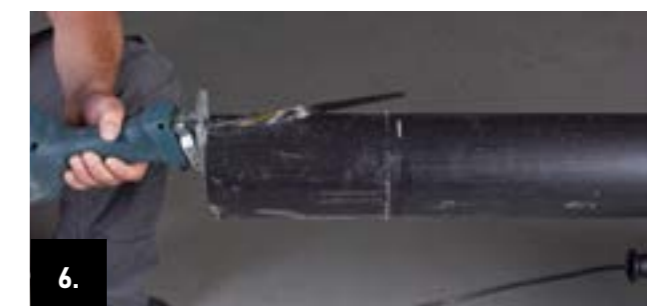
6. Розріжте обсадну трубу до шару поліуретанової ізоляції за допомогою наявної у продажу пилки з полотном для пластику.
