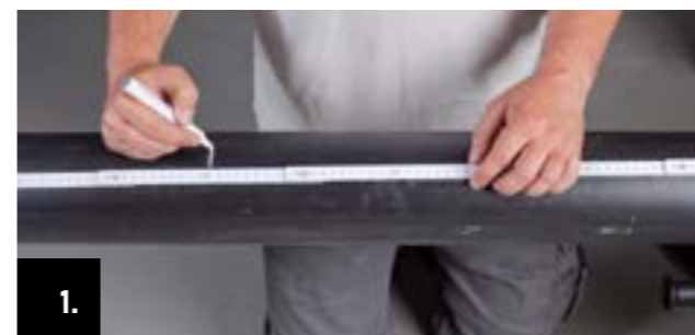
1. Виміряйте довжину труби і позначте її на обсадній трубі.
