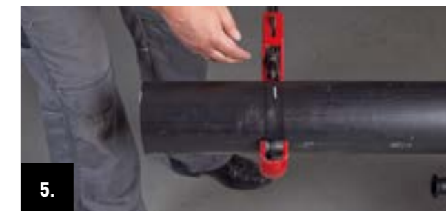
5. Проріжте труборізом по всьому периметру обсадної труби до шару поліуретанової ізоляції.
