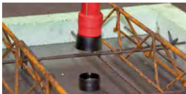
Верхня частина з'єднувальної коробки спринклерів з трубним з'єднувальним елементом вставляється в нижню частину з'єднувальної коробки спринклерів.
