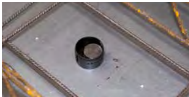
З'єднувальна коробка для спринклерів нижньої секції, арт. 3090000001 для видимих спринклерів. Кріплення за допомогою магніту
