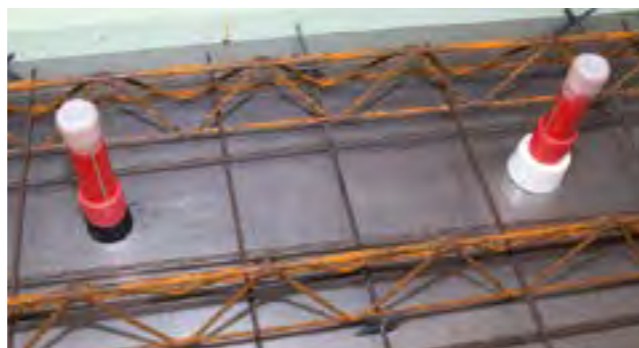
1. Видимий варіант підключення спринклерів
