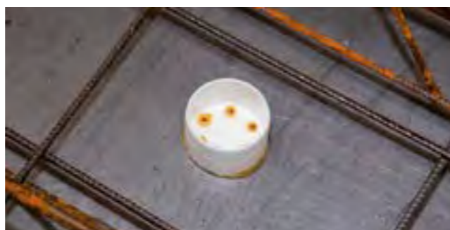
Нижня частина з'єднувальної коробки спринклерів арт. 3090000005 для прихованих спринклерів. Кріплення за допомогою гарячого клею
