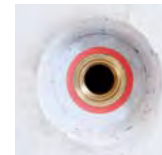
Ілюстрація 3 завершено спринклерне підключення в бетонній стелі
